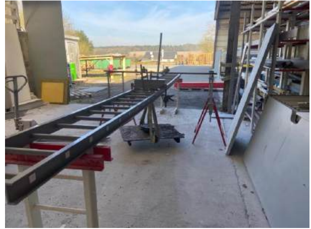
Essai de résistance des montants
